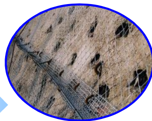
穿孔工と編柵補助金網 生育基盤の保持と、勾配を緩和する目的で編柵補助金網を設置。
