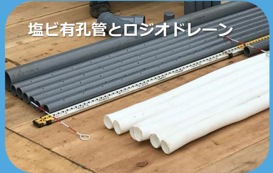
塩ビ管に外挿したロジオドレーン
