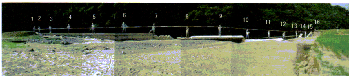
図-1 河川被災箇所の全景写真の例
