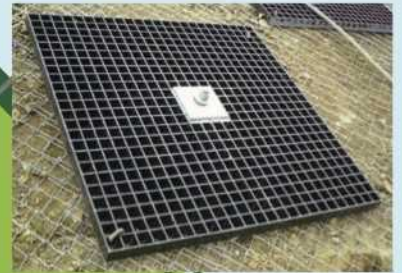
ロックボルト施工例
