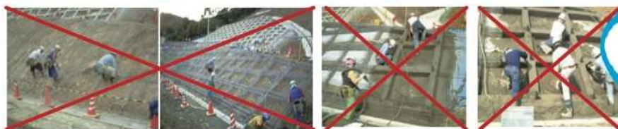
フレーム配筋組立
