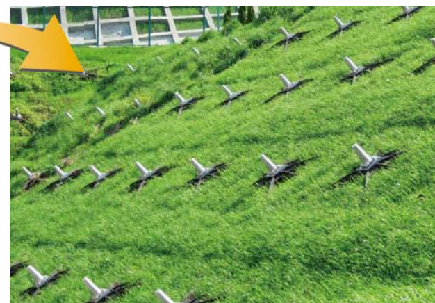
緑化状況(施工後)
