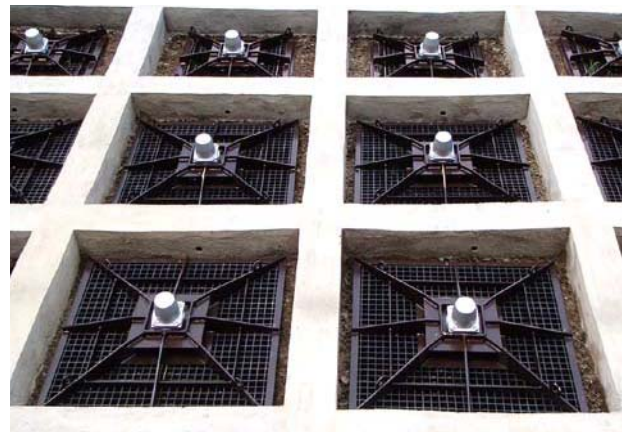
吹付のり枠の補強
