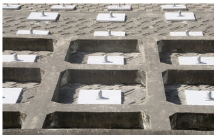
モルタル吹付併用（埋没）
