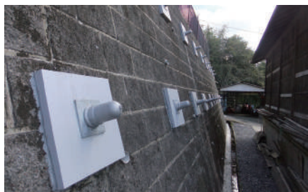
モルタル吹付併用（埋没）
