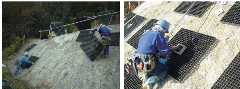
パネル設置 人力で施工
