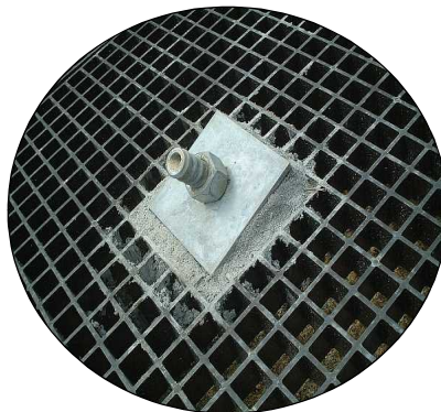
(例) モルタルによる角度調整
