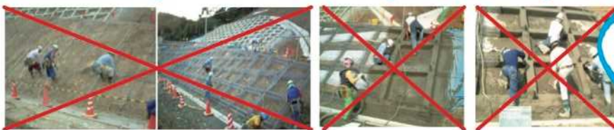
フレーム配筋組立
