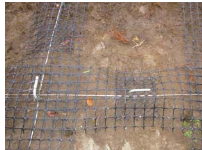
▲ GTアンカー打設完了
