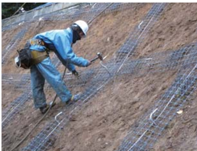
▲ GTアンカー打設状況
