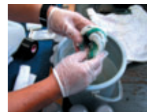
● 100g+100g / 組の主剤と硬化剤の二袋を水解紙のついたまま水に漬け混練します。
