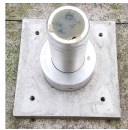
写-3 アンカー頭部
