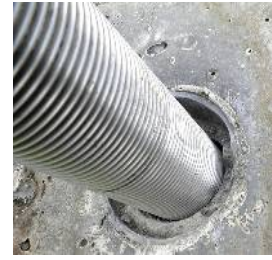
写-4 アンカー頭部
