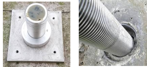
写-2 アンカー頭部
