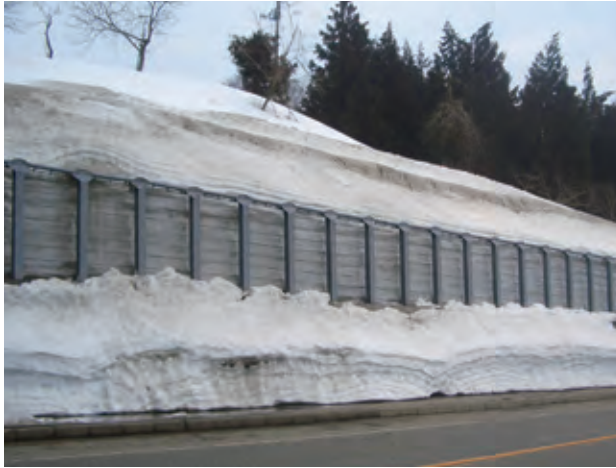
RF-8-SNJ 支柱間隔:1.5m(雪底切対応型)
