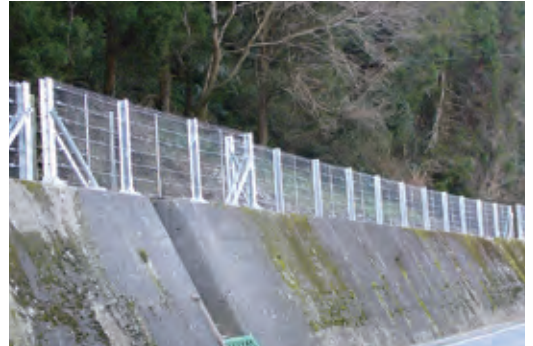
既設擁壁への施工
